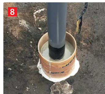
8 根巻コンクリート製作
