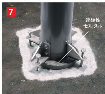
7 速硬(そっこう)性モルタル充填 速硬性 モルタル
